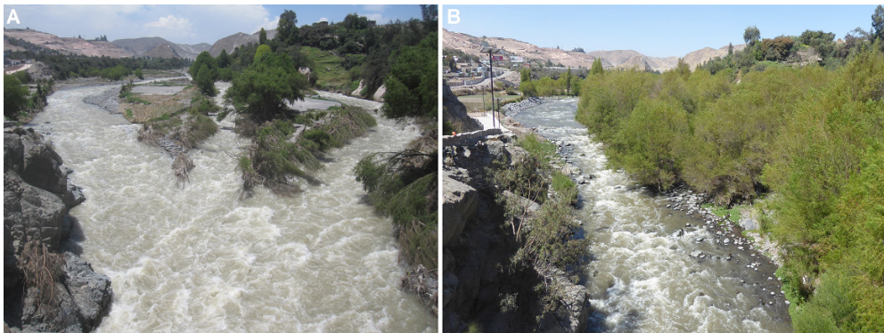
Fig. 5. Río Chili en el distrito de Uchumayo, vista desde el puente antiguo cercano al peaje; A. caudal aproximado de 120m 3 /s en marzo del 2012 donde se denota la erosión causada al monte ribereño; B. caudal reducido en temporada seca (agosto 2017, 4 m 3 /s) donde se aprecia la sucesión secundaria con colonización de Salix humboldtiana . (Fotografías DBMT).
