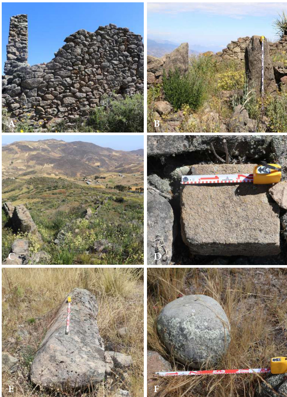
ANEXO 31. A. Unidad 4, detalle constructivo de muro; B. Unidad 4, detalle de acceso; C. Vista panorámica de Unidad 5 desde parte alta de Unidad 4; D. Detalle de piedra canteada; E. Detalle de las dimensiones de las grandes piedras utilizadas; F. Detalle de mano de moler.
