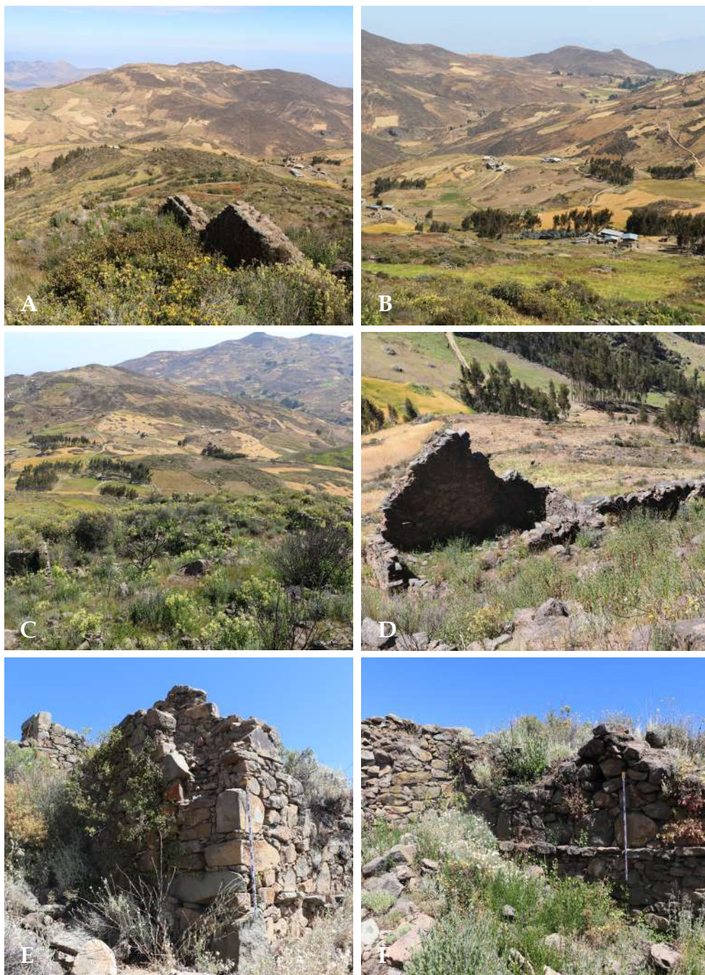
ANEXO 29. A. Vista de Unidad 5 desde parte alta de Unidad 4; B. Panorámica de lado SO de Unidad 4, fondo Quebrada Pada Huambo; C. Panorámica de lado oeste de Unidad 4, parte alta; D. Unidad 4, estructura con muro hastial; E. Unidad 4, detalle de esquina de estructura; F. Unidad 4, detalle de muro con voladizo.
