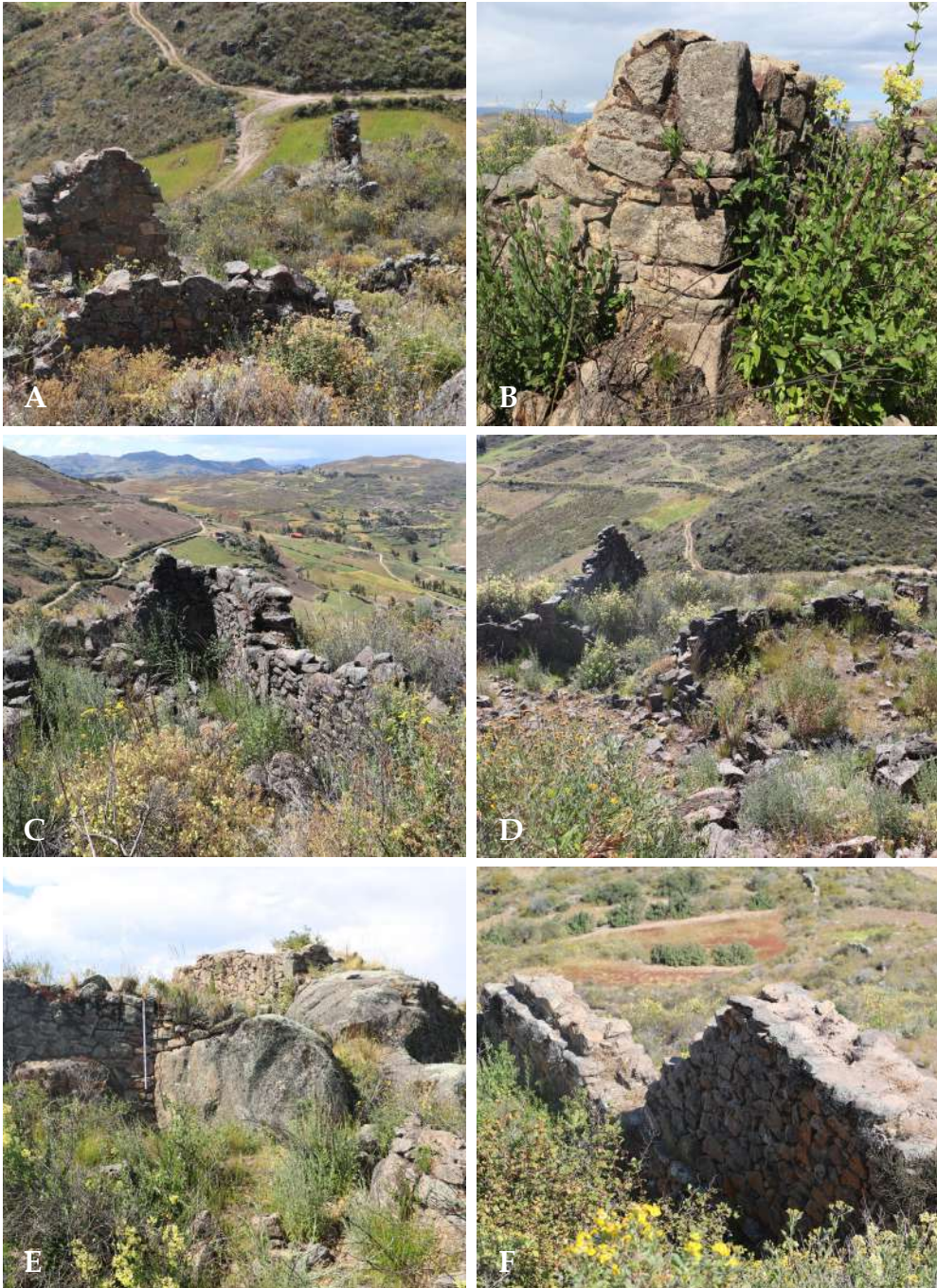
ANEXO 30. A. Unidad 4, detalle del estado de conservación de las estructuras; B. Unidad 4, detalle de esquina de estructura, parte alta; C. Unidad 4, estructura, parte alta; D. Unidad 4, vista de otras estructuras, parte alta; E. Unidad 4, detalle de muro construido sobre afloramiento rocoso; F. Unidad 4, detalle de muro con voladizo.
