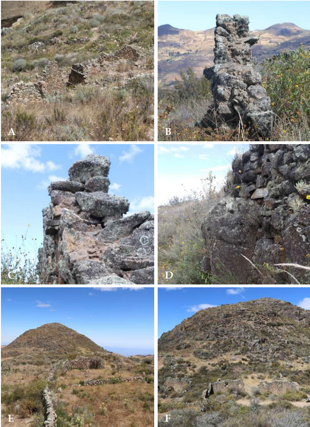
ANEXO 26. A. Otro sector de conjunto arquitectónico, lado este, con voladizos en muro; B. Unidad 2, detalle de muro con voladizo; C. Unidad 2, otro detalle de muro con voladizo; D. Unidad 2, detalle de muro construido sobre afloramiento rocoso; E. Detalle de muralla moderna que cruza la unidad 2. Al fondo Unidad 4; F. Panorámica de Unidad 3, al fondo Unidad 4.
