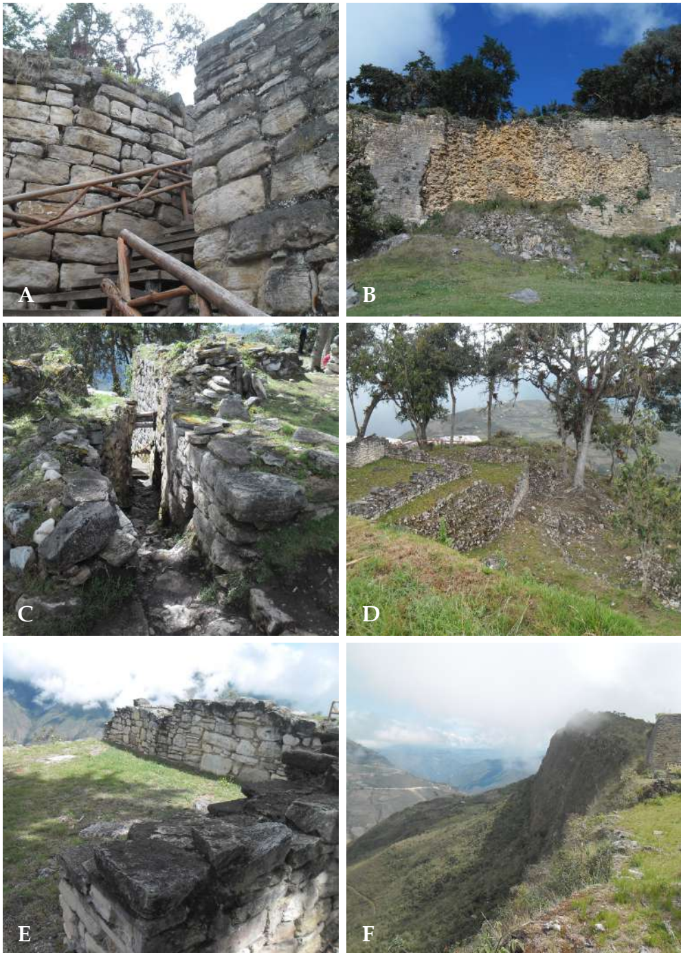
ANEXO 18. A. Vista de detalle de la arquitectura con influencia Inca, B. Detalle del deterioro actual del muro perimetral de Kuélap, C. Vista del acceso al interior de Kuélap, D. Vista de estructuras de planta rectangular, E. Vista de otra estructura de planta cuadrada/rectangular, F. Vista panorámica del área escarpada de Kuélap.
