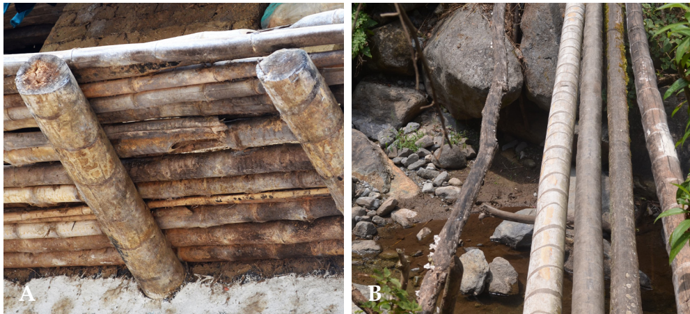
Fig. 5. Usos en construcción de C. parvum en La Oscurana (prov. San Miguel, Cajamarca). A. Techos de viviendas, B. Puentes.
