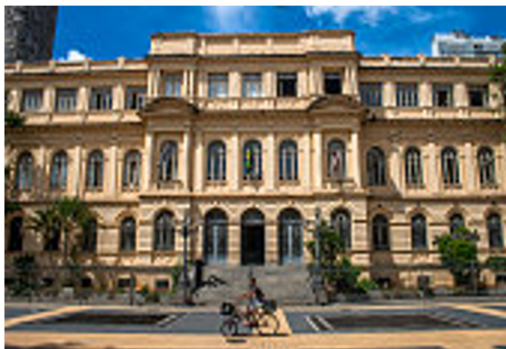
Edifício de la Escuela Normal Caetano de Campos, en Sao Pablo, inaugurada en 1894.
