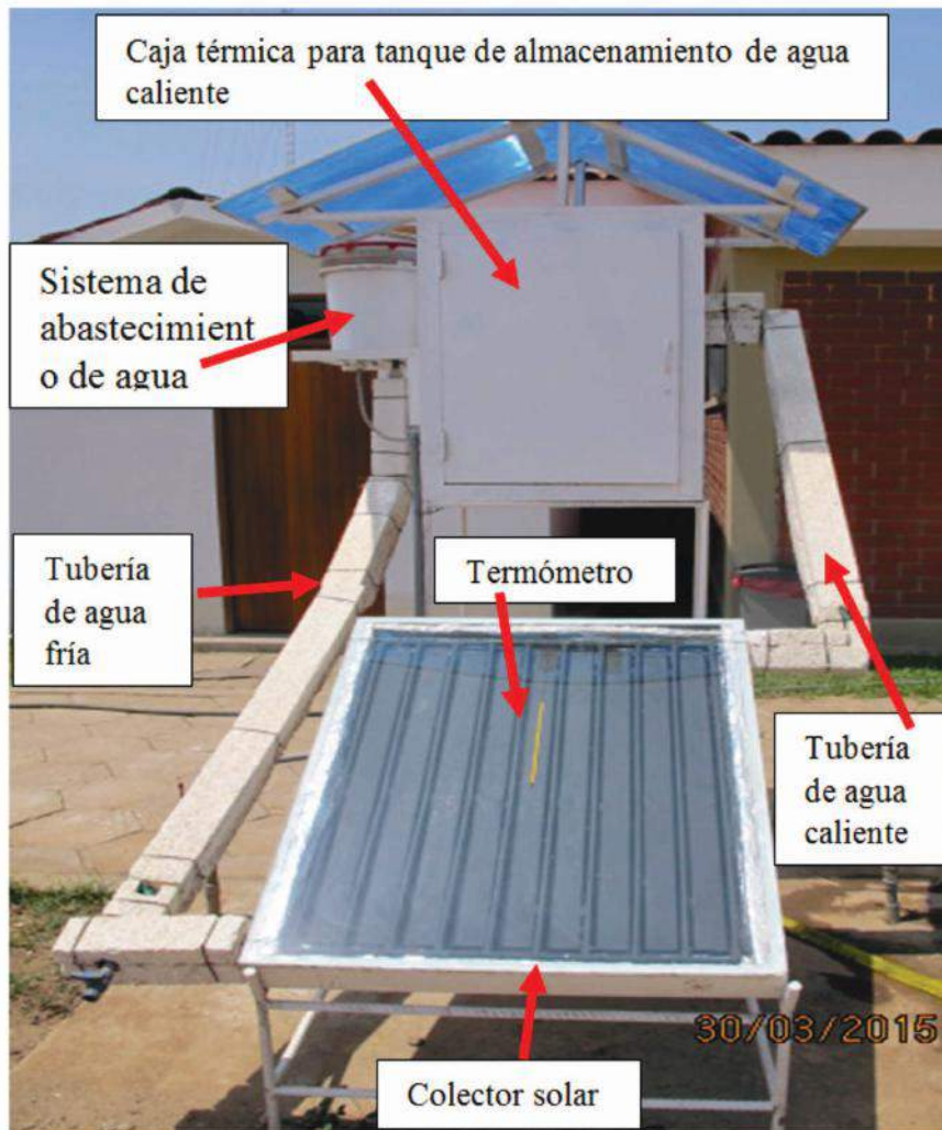
Figura 5. Terma solar instalada en el campus UPAO II.
