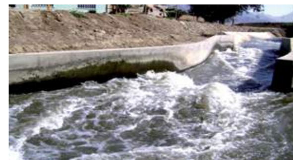
Figura 11. Inicio del Canal Santa Clara, observándose la formación de resaltos
