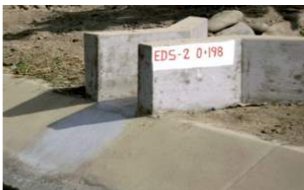
Figura 8. Entrega de desagüe superficial EDS-2, ubicado en la progresiva 0+198.
