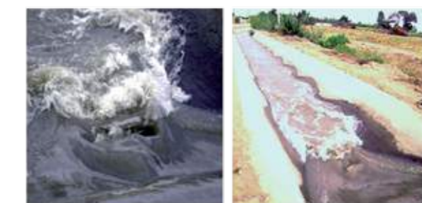
Figura 28-29. Incremento de la formación de oleajes y fenómenos hidráulicos aguas bajo de la estructura metálica
