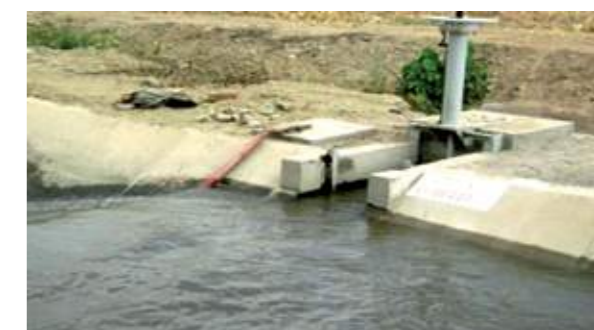
Figura 26. Se muestra la toma lateral y la estructura metálica ubicada para elevar el nivel del agua.
