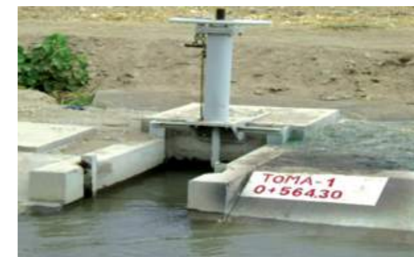
Figura 7. Toma 1 ubicado en la progresiva 0+564.30
