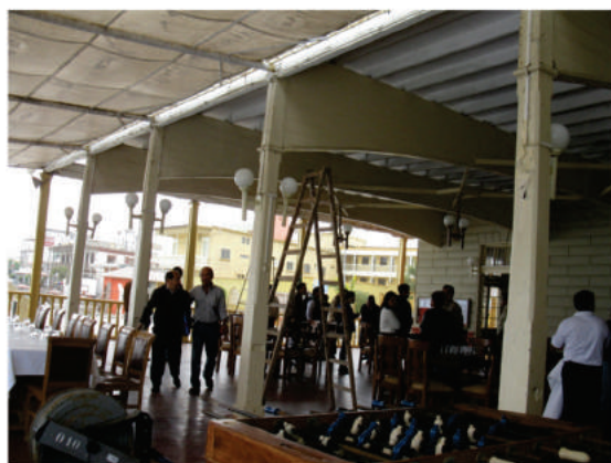
Figura 8. Proceso de inspección y diagnóstico en la terraza.
