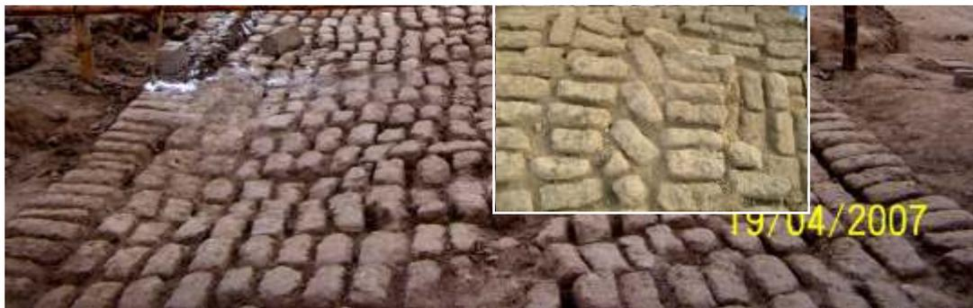
Fig. 05. La falta de engranaje en los adobes, en ambas fotos, en la base del muro perimetral, bien pudo haber causado el fácil derrumbamiento de esa construcción. Se advierte que –a lo más– sólo se los acomodó.
