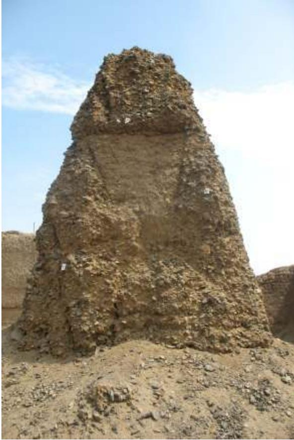
Fig. 07. Muro interior de Rivero hecho con hormigón prensado a manera de tapia.
