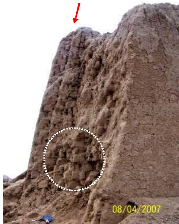
Fig. 04. Véase como se construyó el muro sobreponiendo “capas” de adobes las que al final se desprenderían. El “hito humano” en el círculo.
