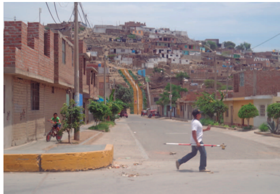
Figura 6 y 7: Levantamiento topográfico en badén y calle Hipólito Unanue.
