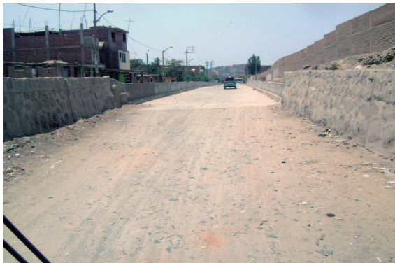
Figura 5: Muros de roca
