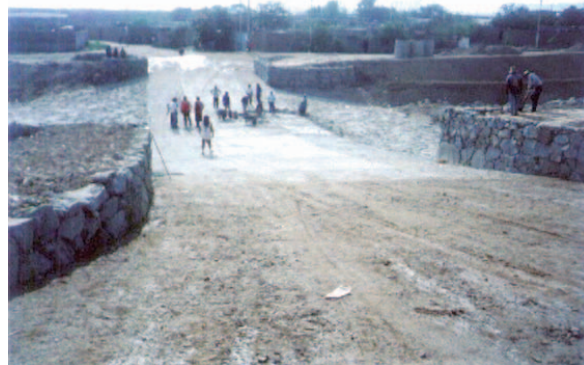
Figura 3: Badén de concreto
