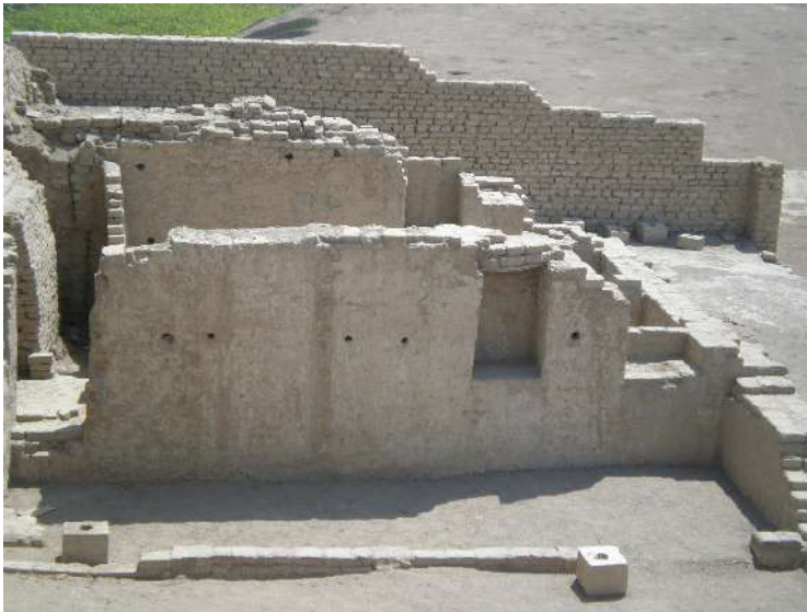
Figura 32. Detalle del sector suroeste de la plataforma superior de D (vista N-S), con recintos pintados de blanco, alineados al exterior del muro oeste del patio (Foto: C. Gálvez).
