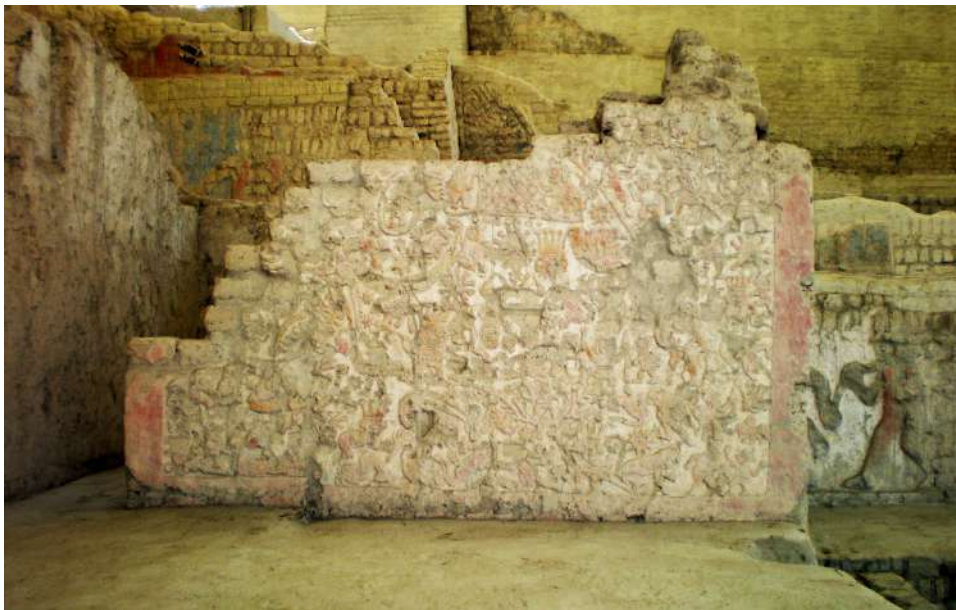
Figura 20. Recinto esquinero sobre plataforma en la plaza de A (vista N-S) (Foto: C. Gálvez).
