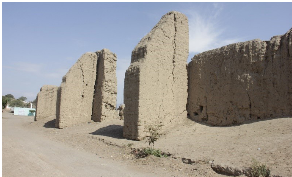
Fig. 5: Vista noroeste de la fachada externa del muro norte del Santuario, mostrando la alineación de los contrafuertes que aún permiten identificar la altura y forma de los mismos.
