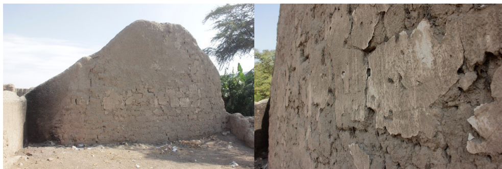
Fig. 9: Margen izquierda se observa un muro completo con la parte superior adaptada para techo a dos aguas, vista desde el interior del pabellón Oeste. Margen derecha se observa el detalle del enlucido en proceso de meteorización erosión.
