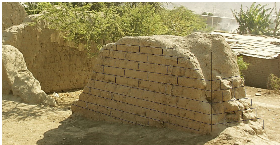
Fig. 10: Vista desde noreste de uno de los muros perimetrales del pabellón oeste, donde se ha resaltado digitalmente el tramado de los adobes, técnica constructiva que se replica en los demás pabellones del monasterio.
