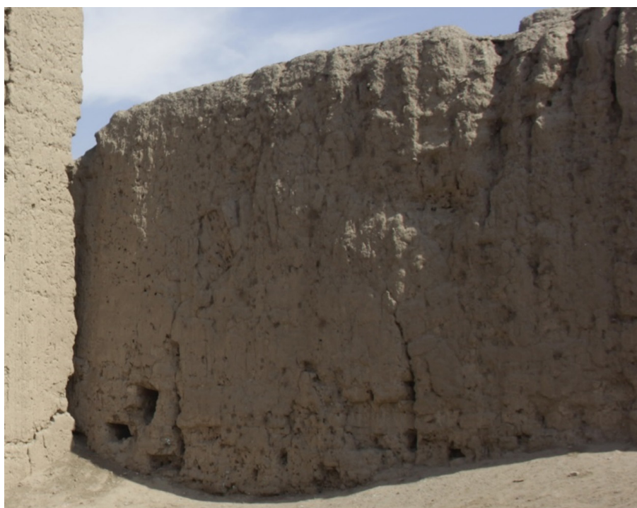
Fig. 6: Vista noroeste del arco ciego ubicado en el muro norte, o pared derecha, del santuario.
