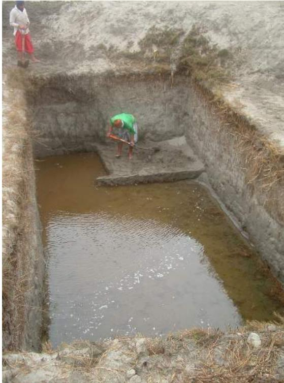
*Figura 7.* Poza artificial en excavación. Nótese el afloramiento de agua. (Foto: Elías Rodrich).
