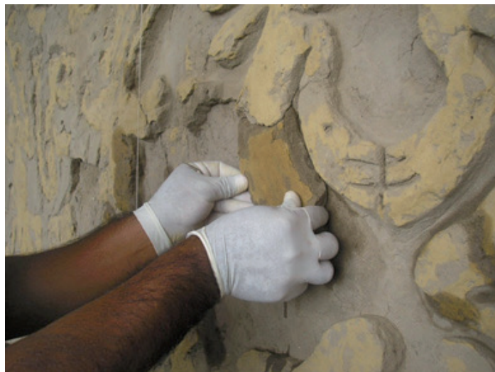
Figura 14. Procedimiento de readherencia.
