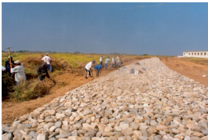
Figura 17. Mejoramiento de carretera de Chotuna y Chornancap.
