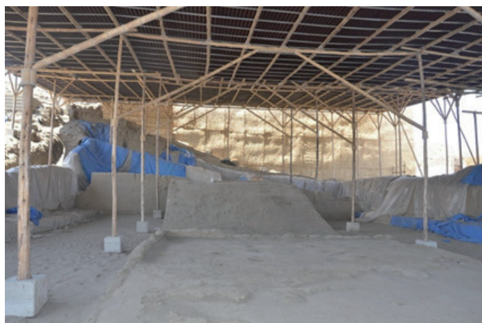
Figura 13. Instalación de cubiertas con Onduline.
