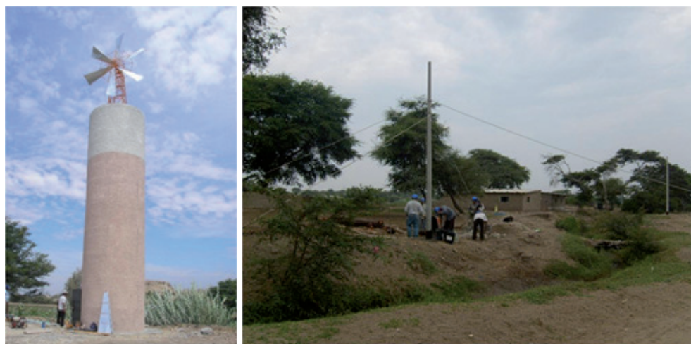
Figura 18. Instalación de luz y agua en los doce caseríos de Chotuna Chornancap.
