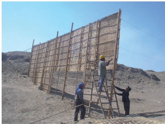
Figura 12. Instalación de cortavientos.
